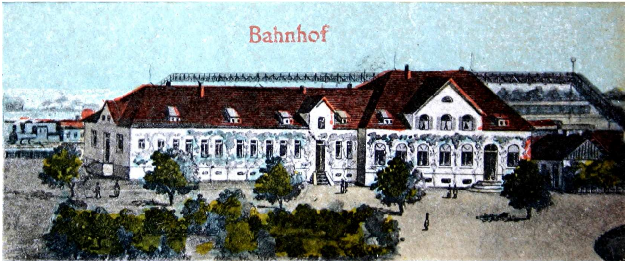
Darstellung des 1911 eingeweihten neuen Reutiner Bahnhofsgebäudes für Nahverkehrszüge bereits rechts mit dem Fußgängersteg über das Gleisfeld auf einer Postkarte mit dem Stempel vom Juni 1926. Bild: Sammlung Dietlein
