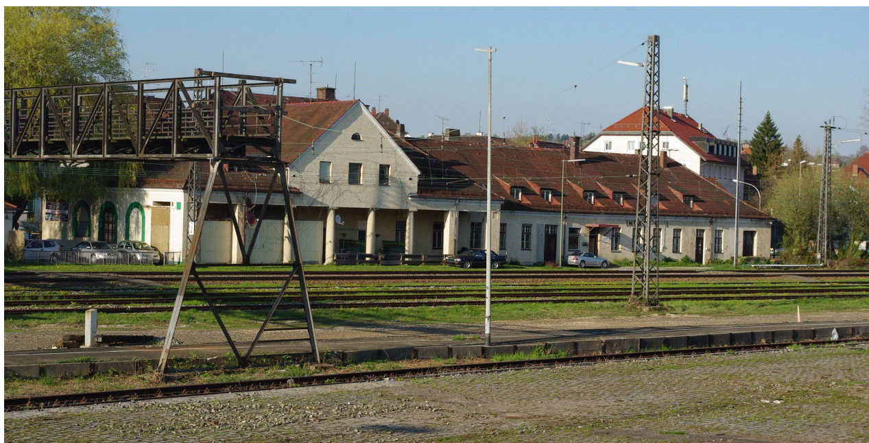
Südseite der ehemaligen Station Reutin mit zerstörtem ehemaligen Fußgängersteg im April 2011. Foto: Schweizer
