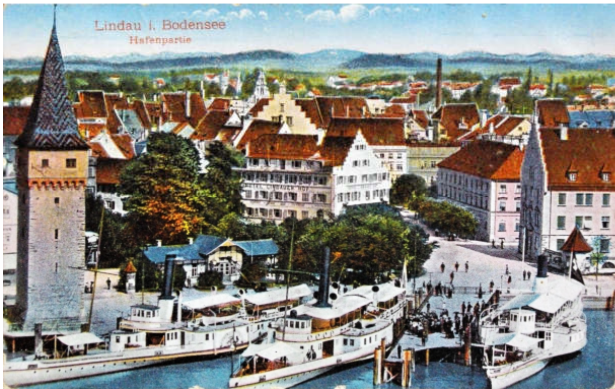
Blick auf Lindaus nordöstlichen Hafenbereich um ca. 1910 mit dem Tatort von 1906, der Dampfschiffwartehalle samt Toiletten rechts neben dem Mangturm auf einer colorierten Postkarte des Trinksverlags. Sammlung Schweizer, Lindau.
