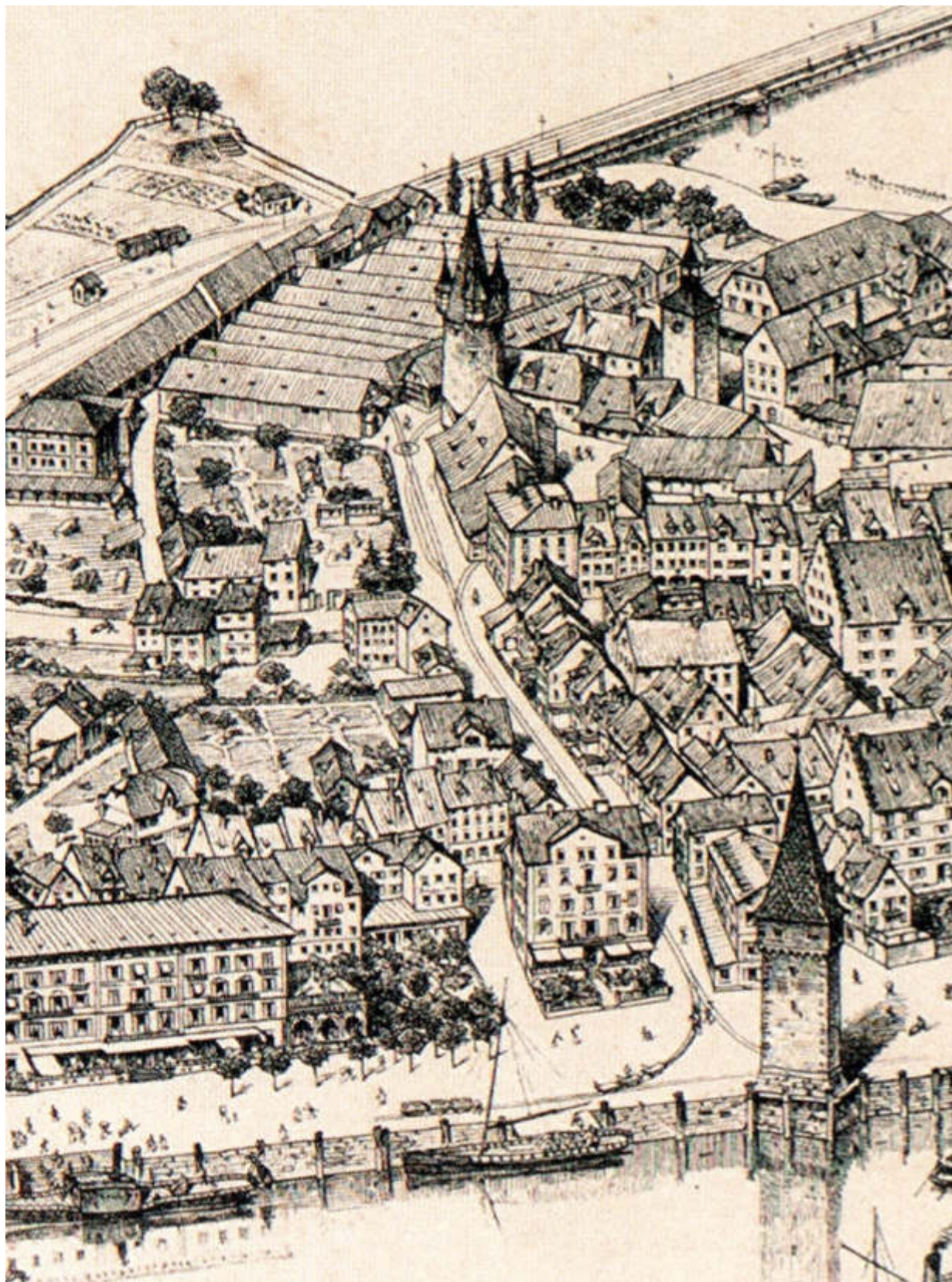
Die alten Lindauer Kornhäuser rechts bei der Peterskirche sowie die neuen Getreideschuppen mit Bahnanschluss westlich der Stadtmauer samt der 1862 mit Eisenbahnschienen errichteten Rollbahn durch den „Inselgraben“ für den Transport des Getreides zum Lindauer Hafen. Stahlstich von P. Pfann und J. Egg, Fotolitho von Dr. C. Wolf et. Sohn, München, 1886. Sammlung Schweizer.
